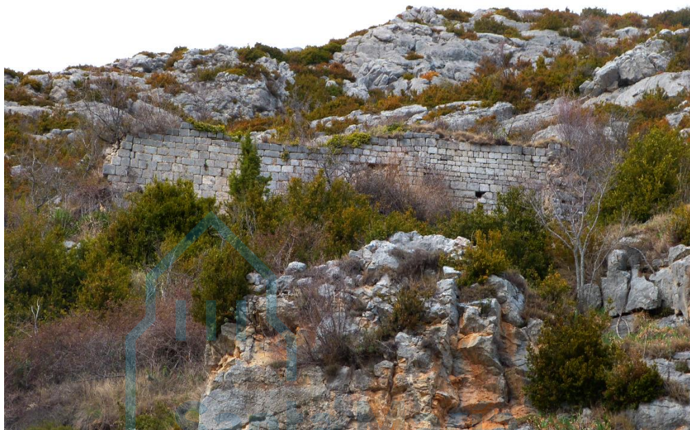
Restos del muro sur
