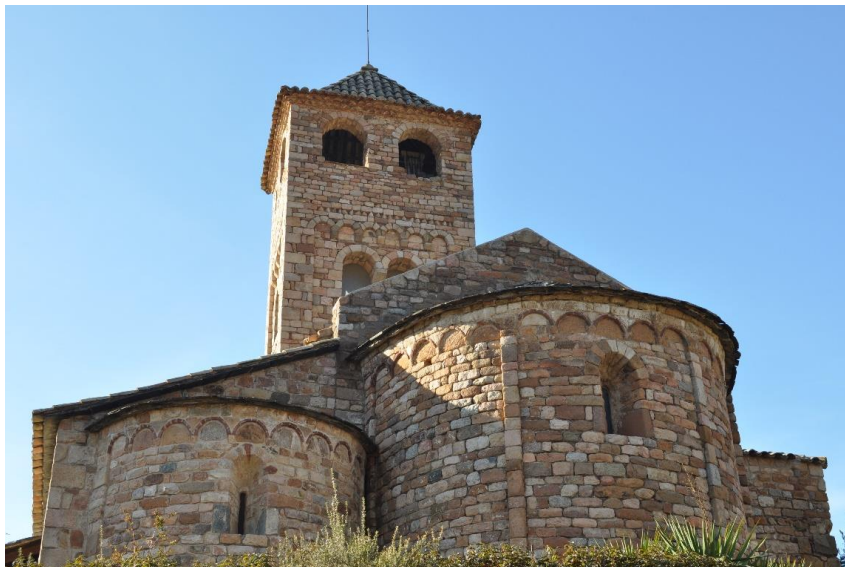
Vista general de la cabecera
