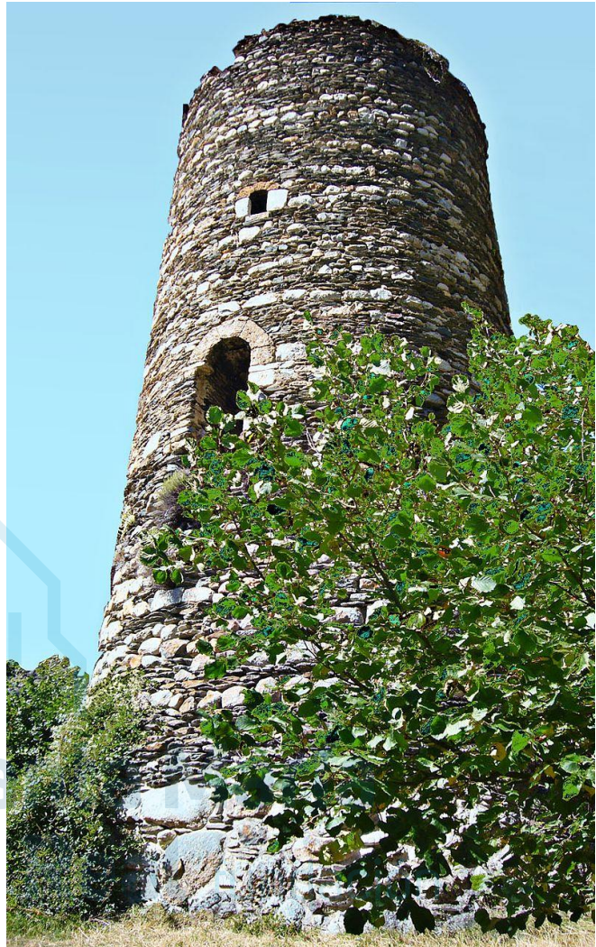
Vista de la torre. Foto: Elena Fàbregas (CC BY SA- 4.0)
