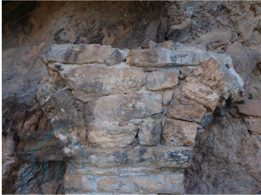
Restos del arranque de dos arcos
