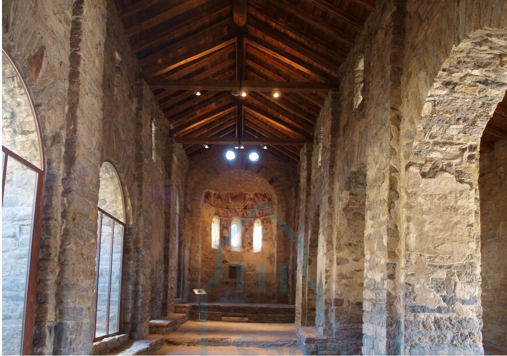
Interior de la nave central
