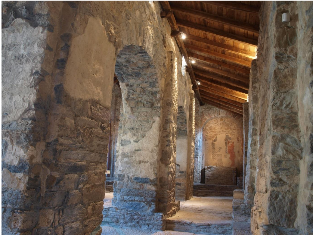
Interior de la nave sur
