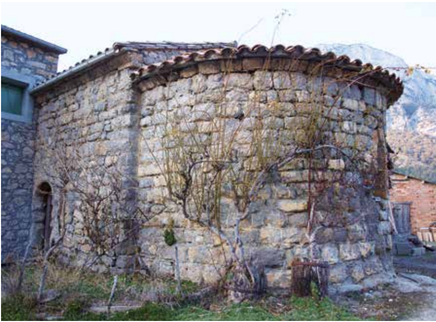
Ábside y muro sur
