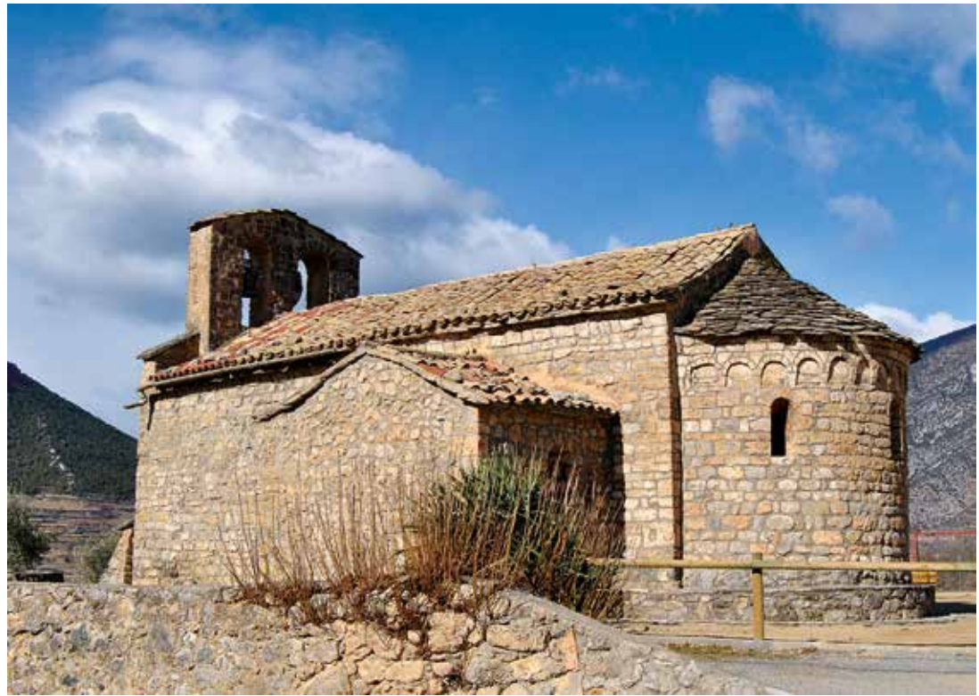
Vista general desde el Sureste
