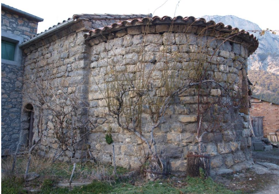
Ábside y muro sur
