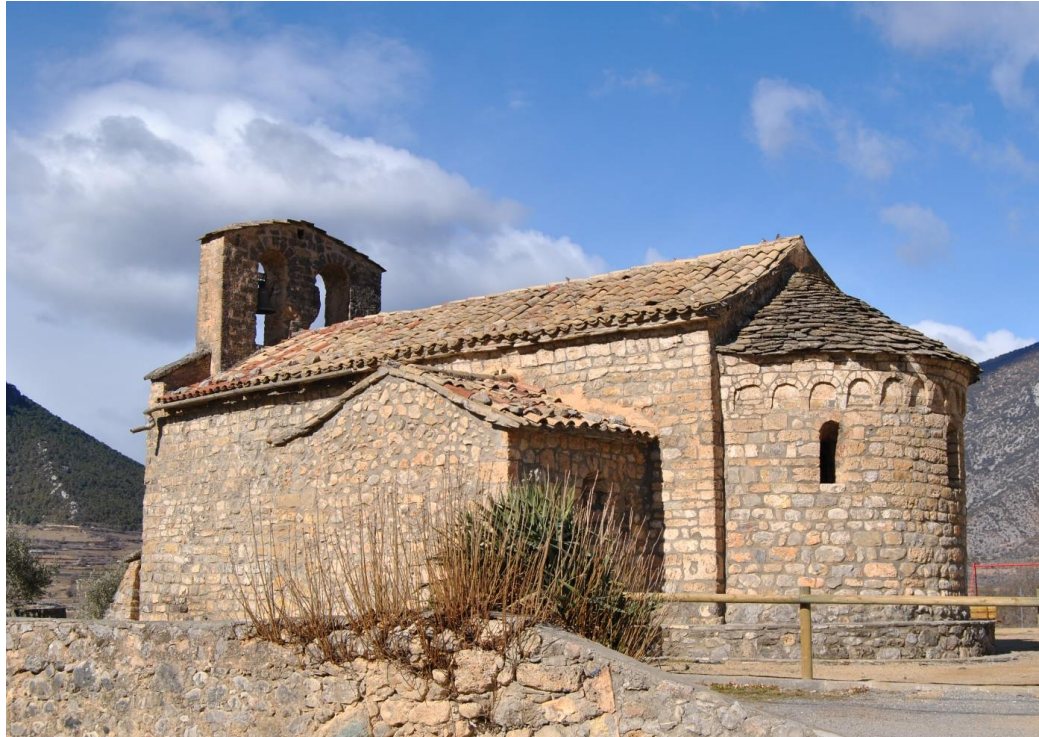
Vista general desde el sureste
