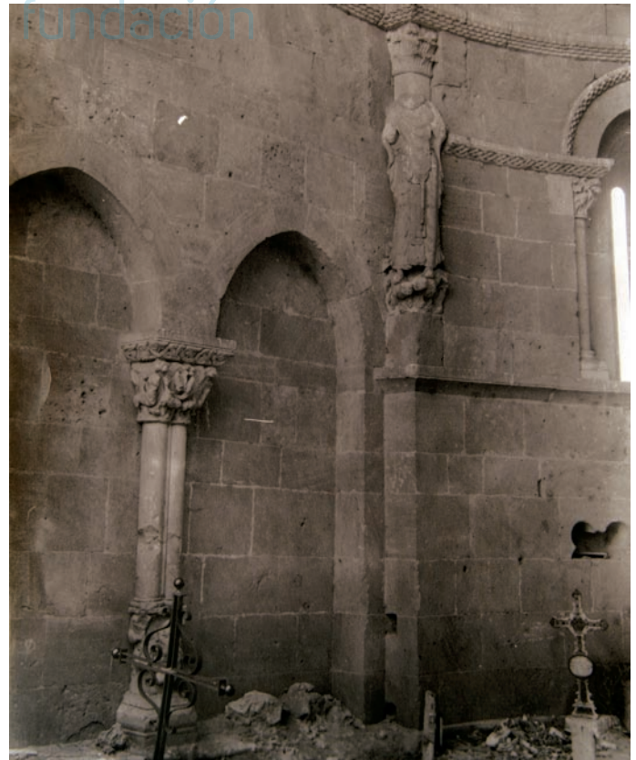
Detalle del interior del ábside in situ (Real Academia de Historia y Arte de San Quirce)
