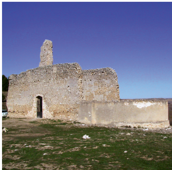
Estado actual de las ruinas
