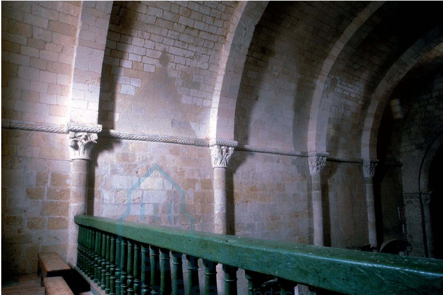
Bóveda y fajones de la nave
