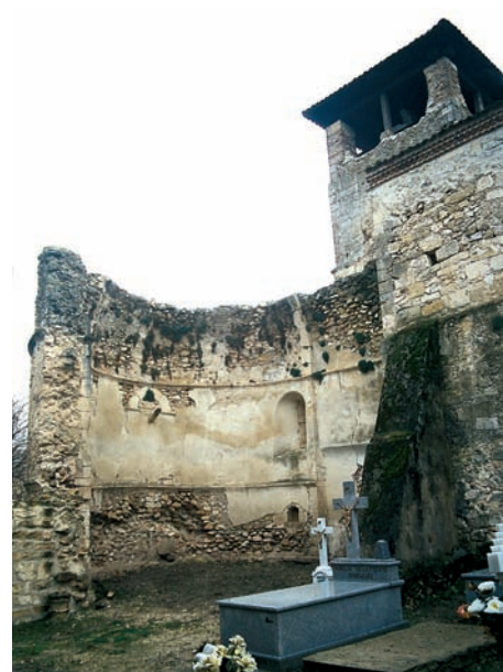
Interior del ábside
