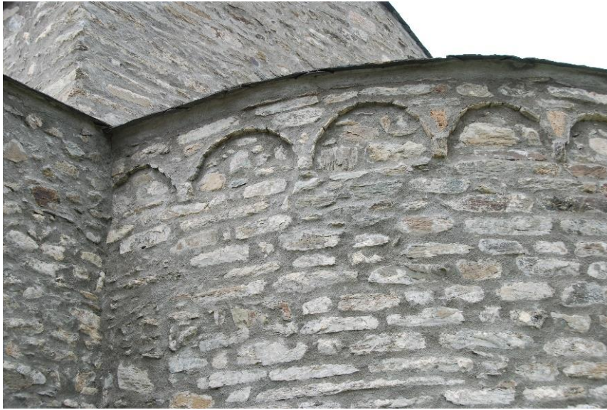
Detalle de arcos ciegos en el ábside
