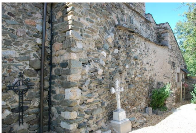
Muro lateral con arco tapiado
