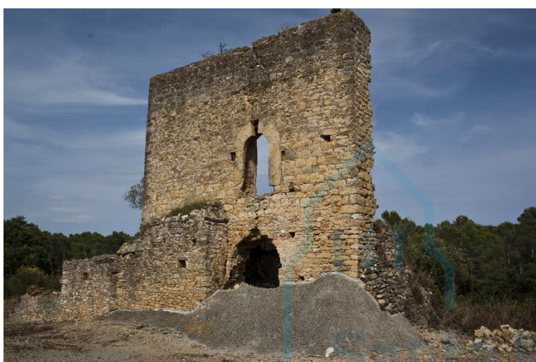
Restos de la torre
