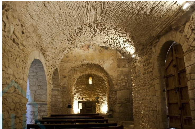
Interior (nave prerrománica)
