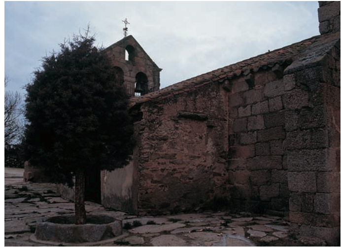
Detalle de la fachada sur
