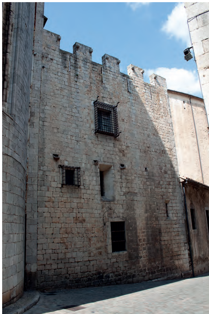
Façana nord de la sagristia
