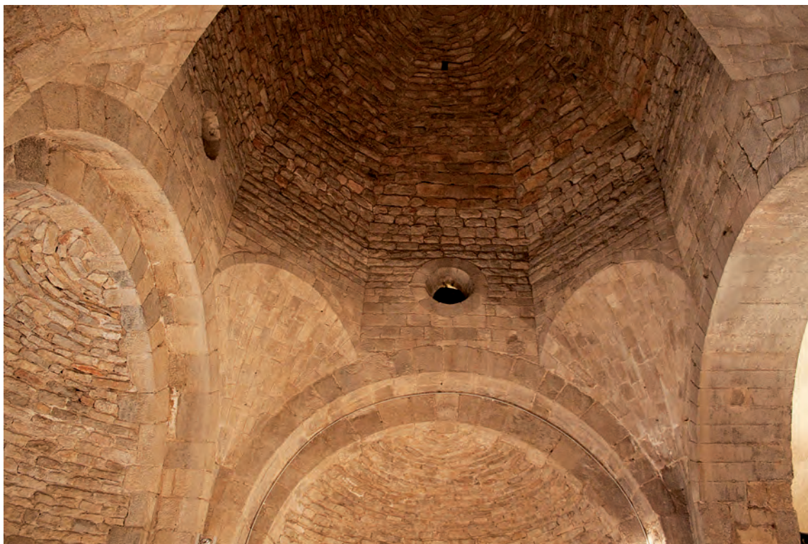
Vista interior del cimbori
