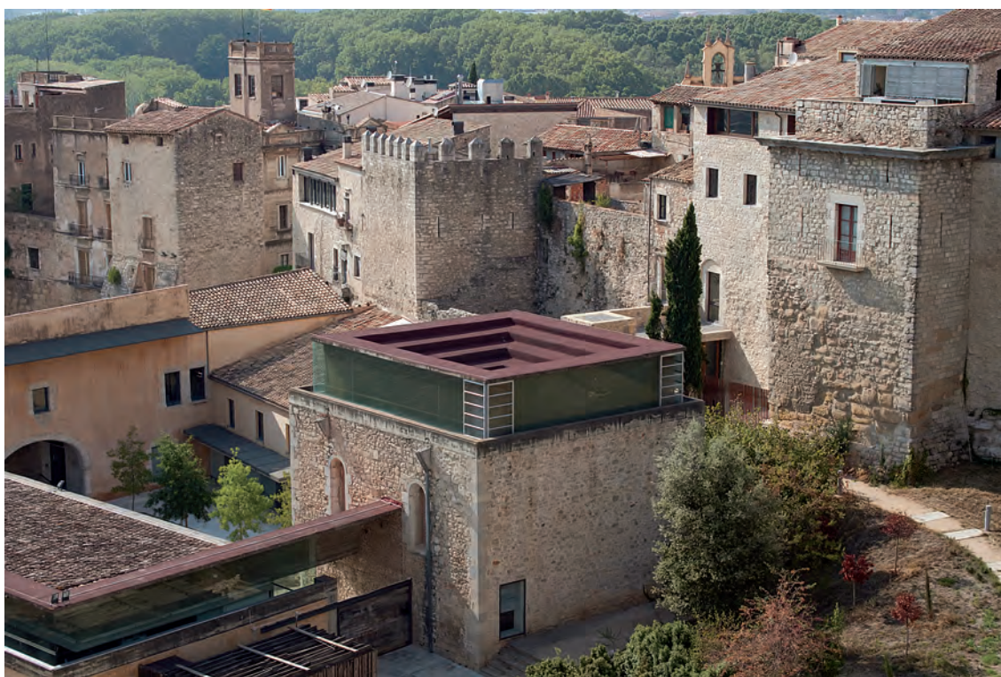
Sector de muralla al costat de l'edifici de les Àligues (rectorat universitari)
