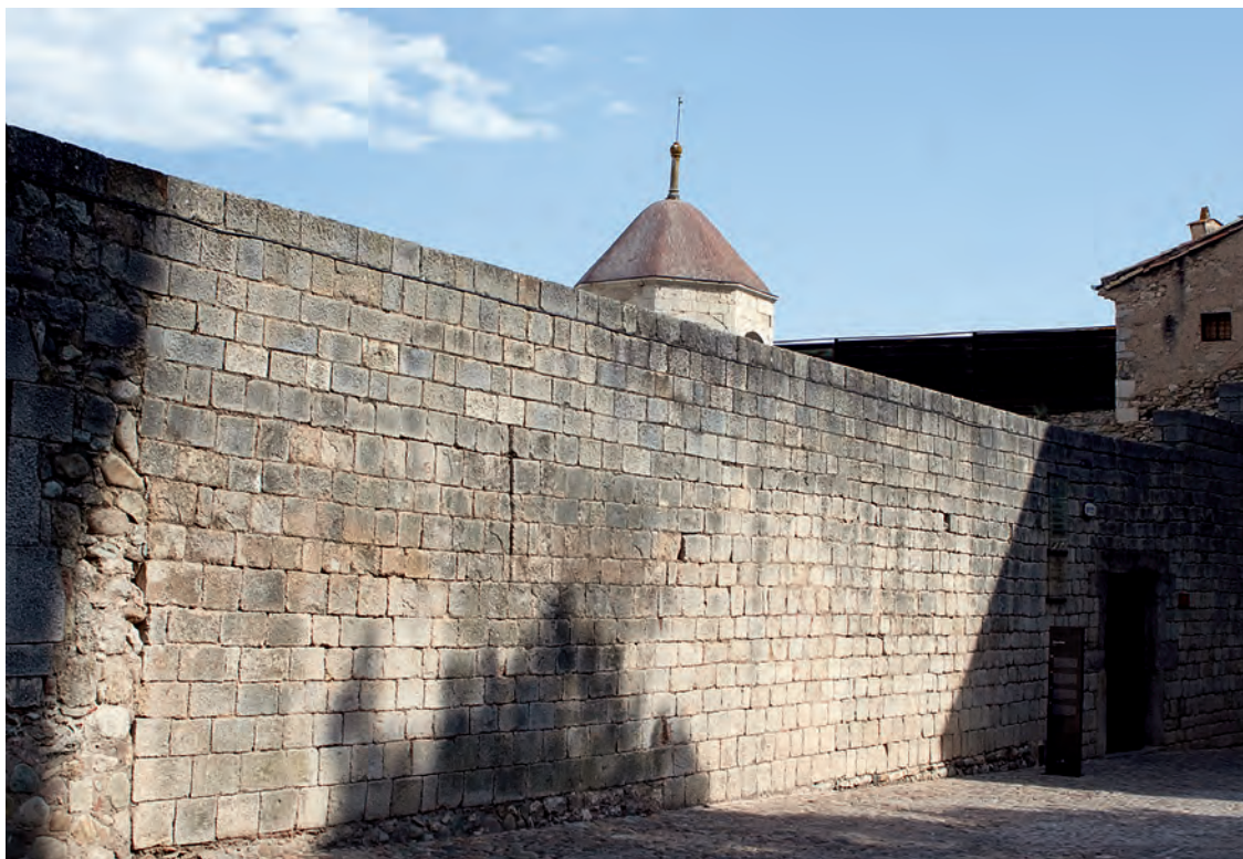
Façana exterior del conjunt
