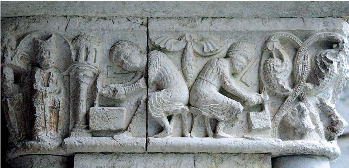
Relleu del pilar de la galeria occidental, amb el bisbe beneint les obres de construcció del claustre (XI.b., XI.a. i XI.b.)
