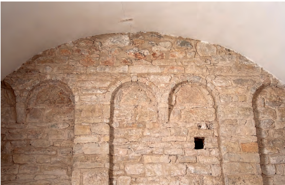
Mur nord de l'església vist des de l'interior de l'hostatgeria
