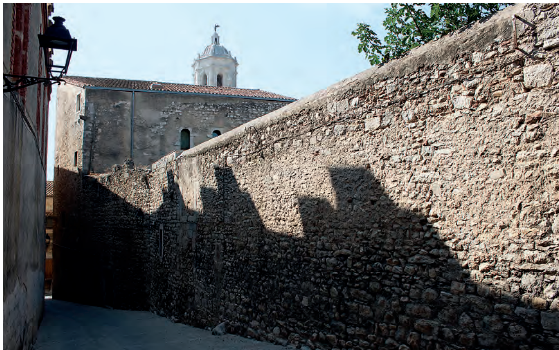
Vista des del carrer dels Alemanys, amb el campanar catedralici de fons
