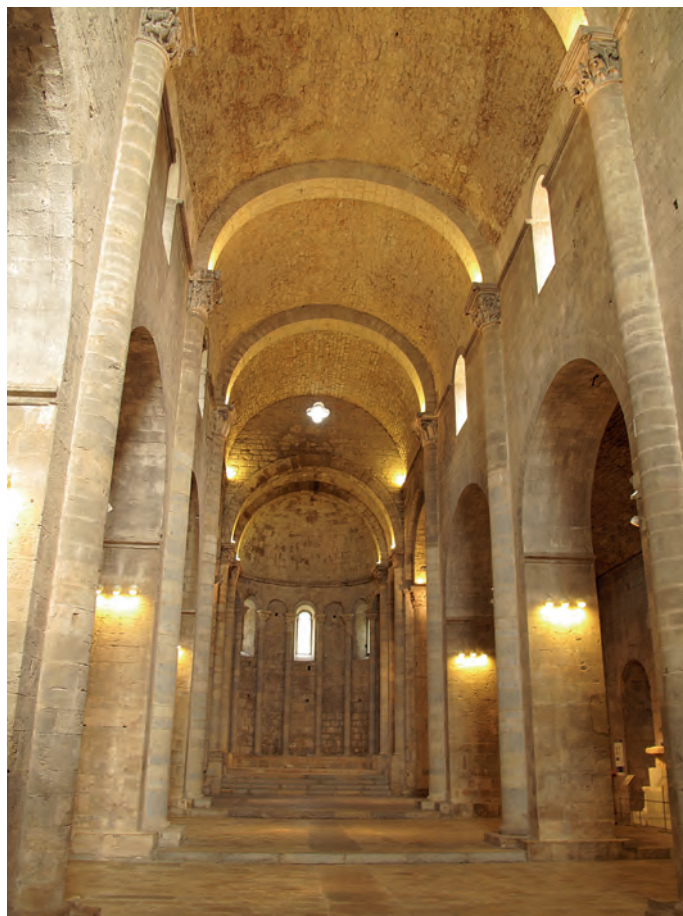
Interior de la nau central vers la capçalera
