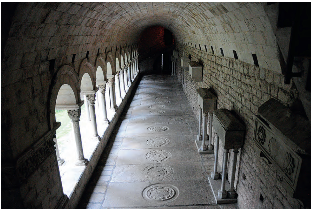
Interior de la galeria septentrional, coberta amb volta de canó sobre el mur del segle XI de tancament del pati
