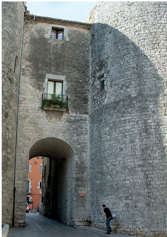
Portal de Sobreportes
