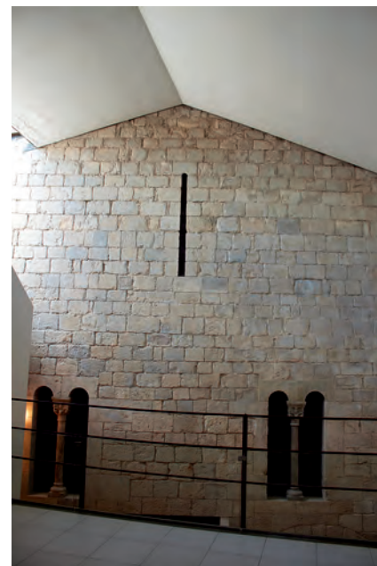
Antiga façana sud del palau (a l'actual saló del tron)
