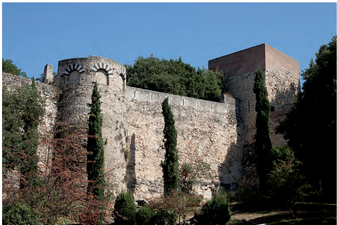
Llenç de muralla entre el carrer dels Alemanys i les Àligues (torres 7 i 8)
