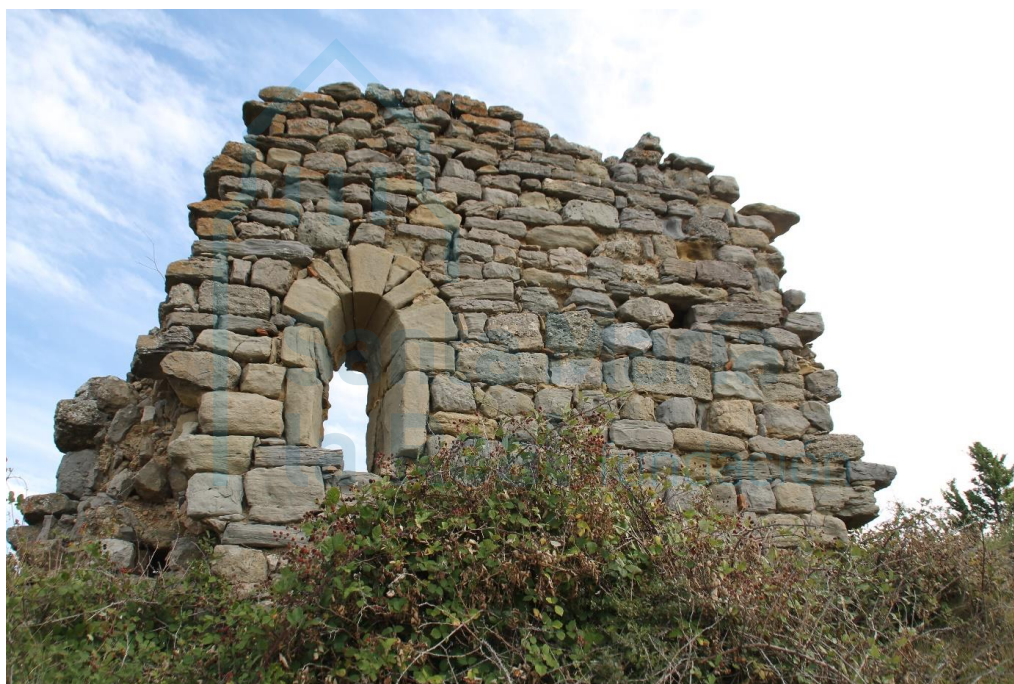
Restos del interior del muro norte de la iglesia
