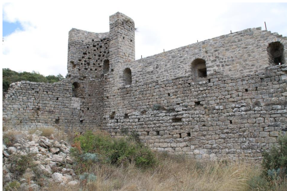
Vista del interior de la muralla y de la torre sureste
