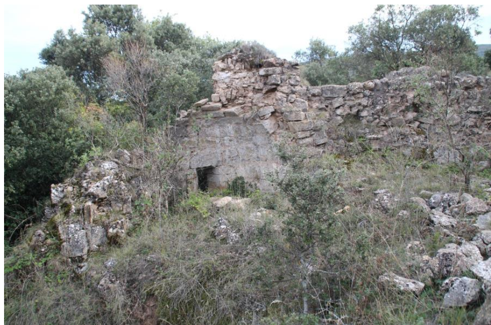
Restos del absidiolo sur y de muro meridional
