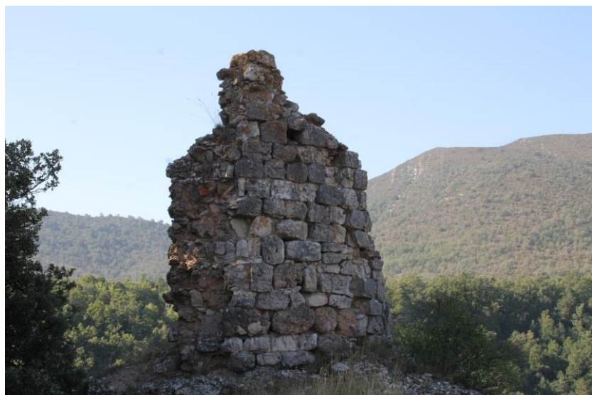
Restos del muro
