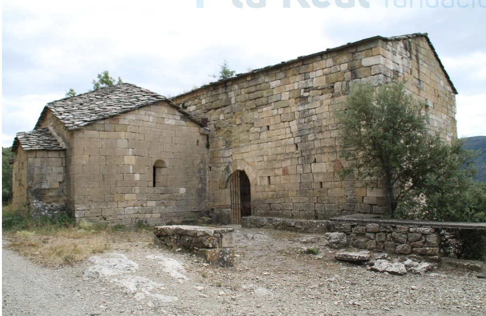
Vista general desde el noroeste
