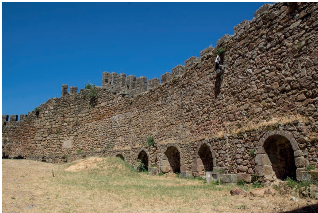
Sistema de seteiras rasgadas na base da muralha voltada a Leste (vista interior)
