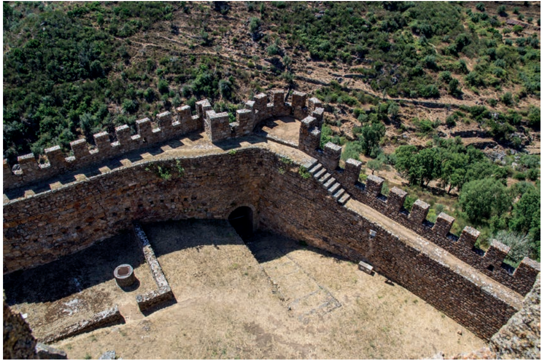
Adarve na zona da Porta da traição
