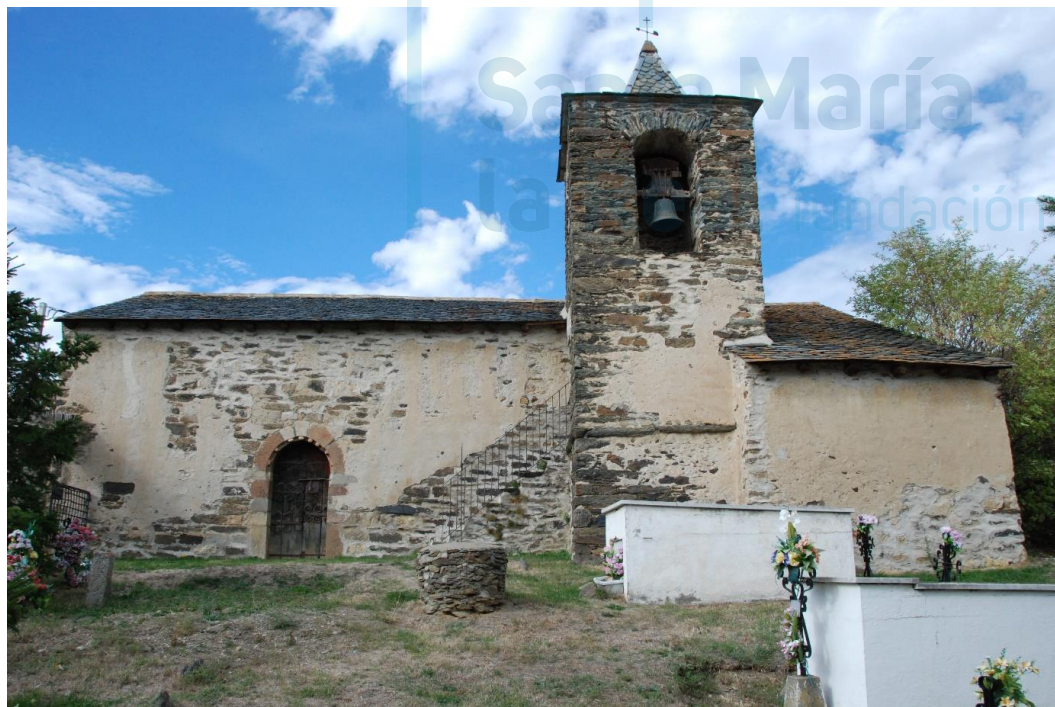
Vista general desde el lado sur
