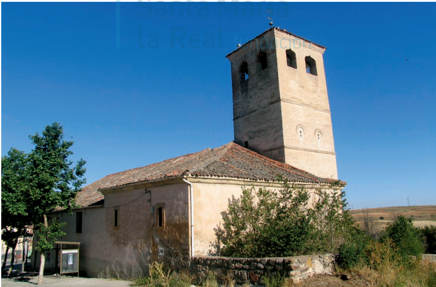
Exterior de la iglesia de San Vicente
