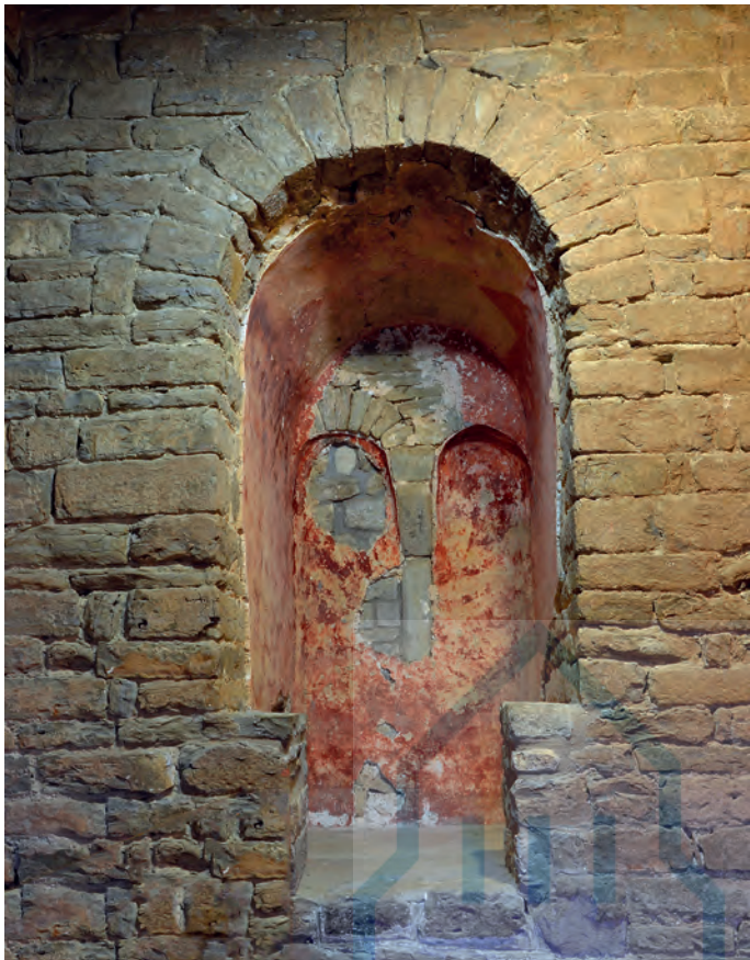
Ventanal cegado del tercer piso
