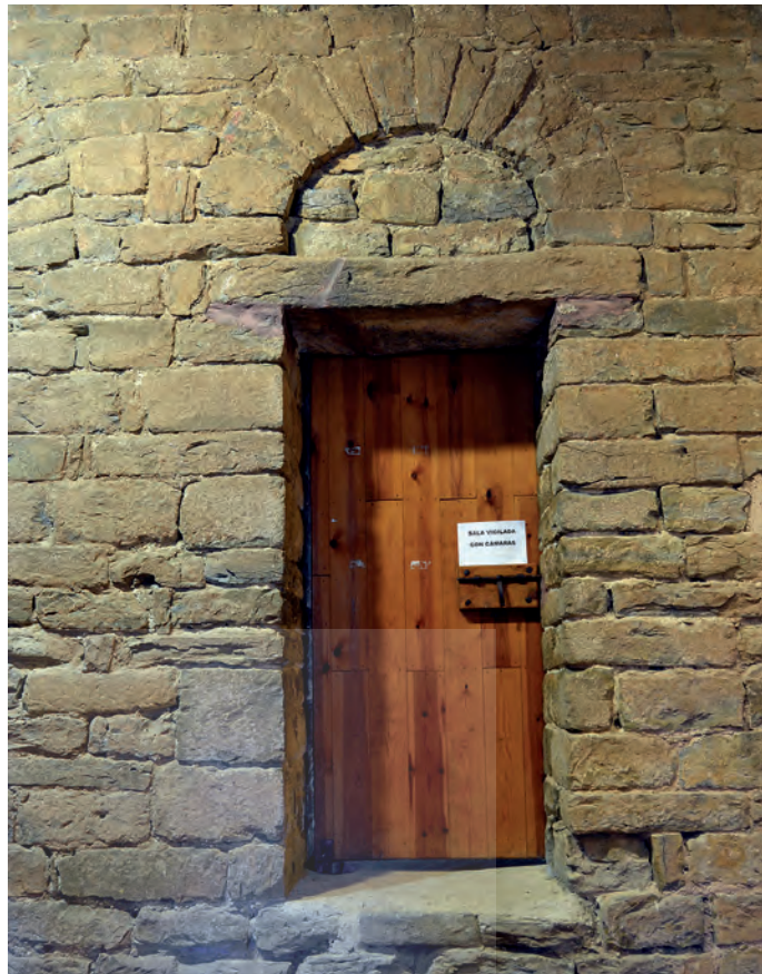
Puerta del tercer piso
