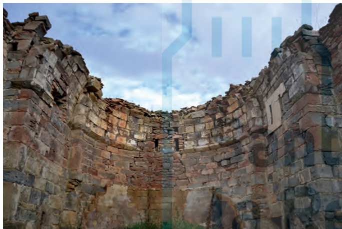
Interior del ábside
