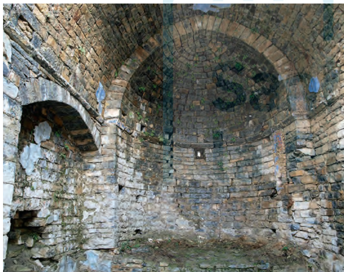
Interior del ábside
