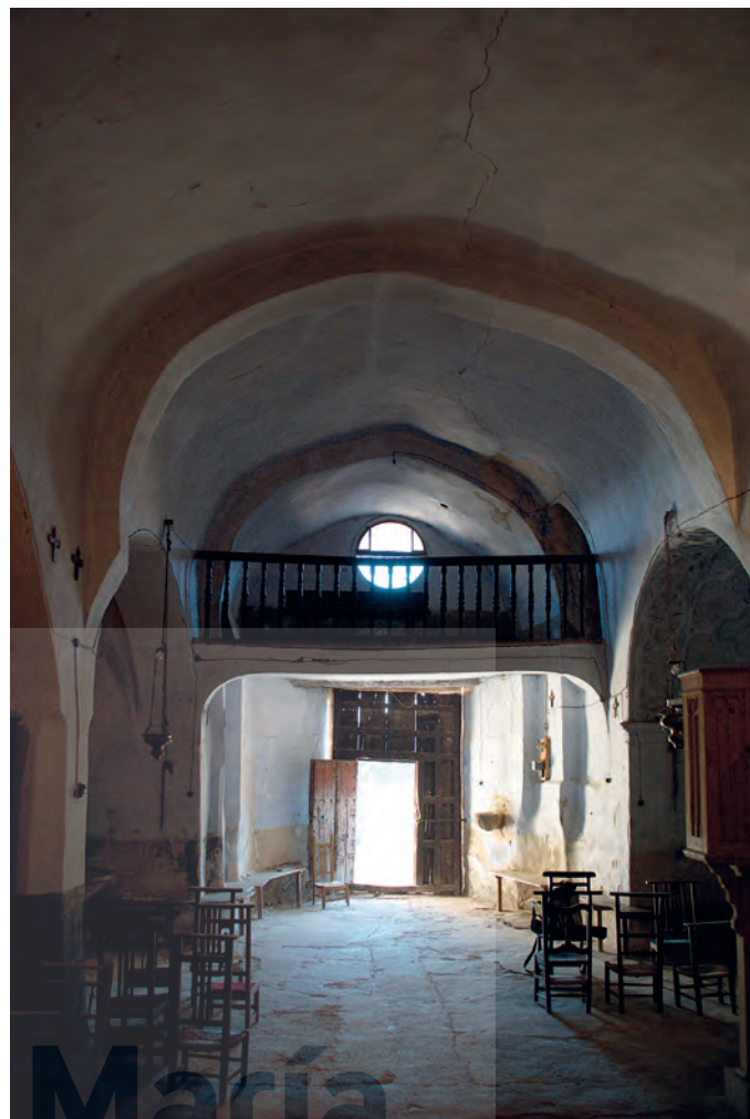
Interior de la iglesia con el antiguo ábside al fondo
