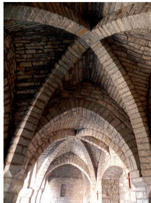
Galería del claustro
