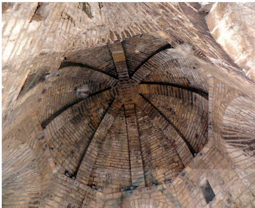
Bóveda del cuerpo superior de la torre
