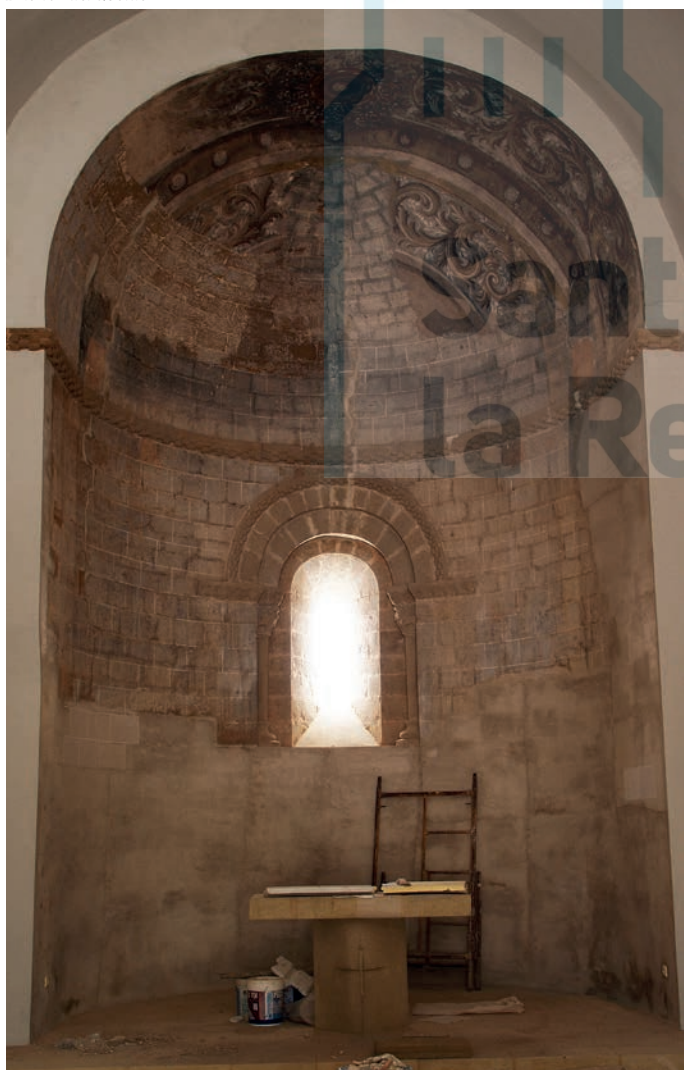
Interior del ábside
