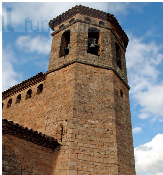
Ábside y torre
