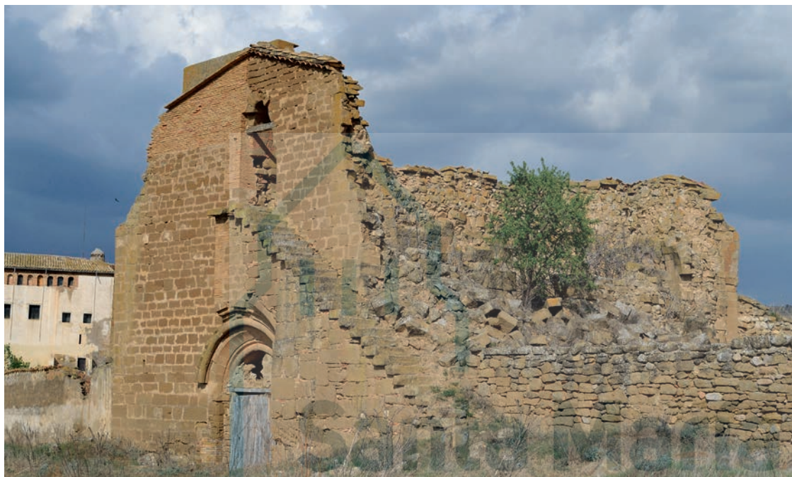
Vista general de la iglesia mayor
