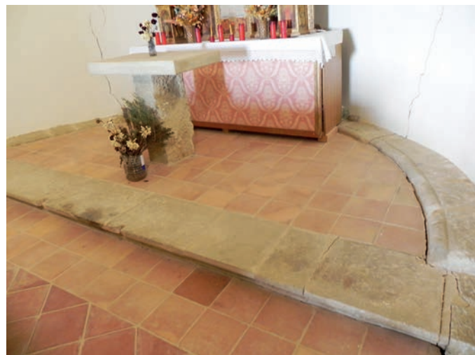
Restos del banco corrido del ábside
