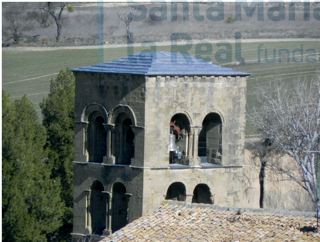
Vista de la torre
