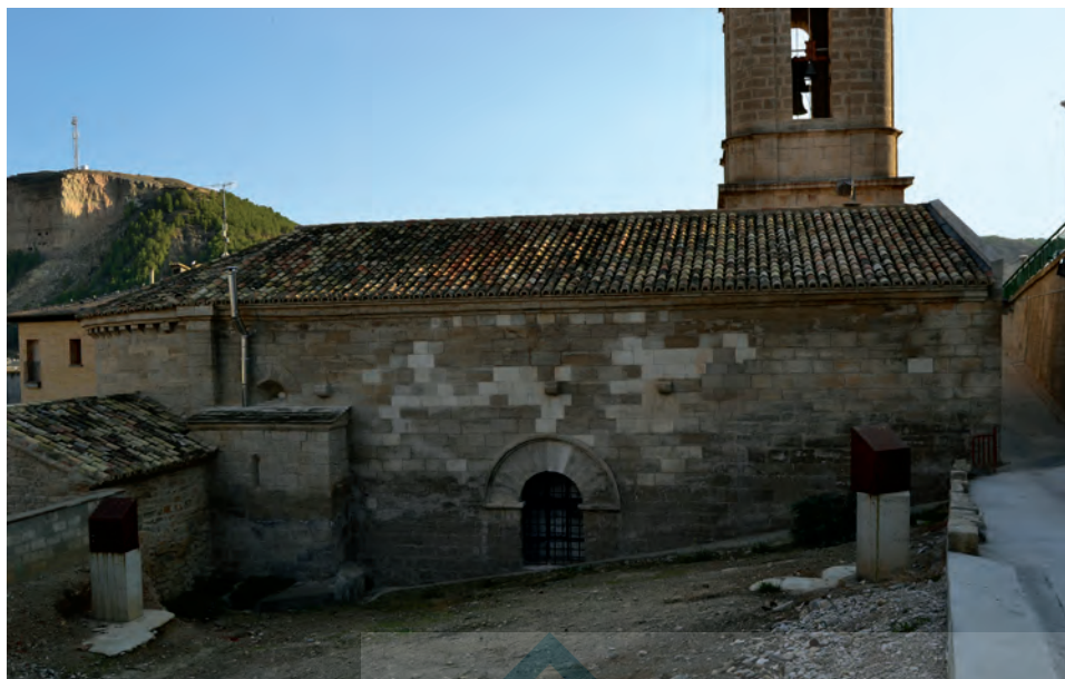
Vista desde el lado norte
