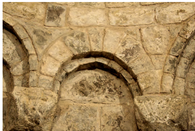
Arquería interior del ábside central
