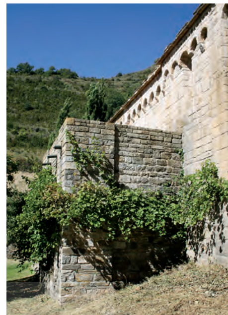
Vista del muro sur con la torre lombarda inconclusa
