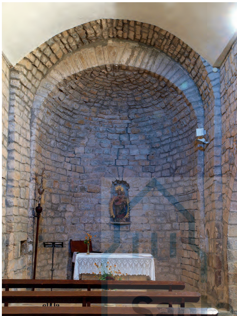
Interior del ábside
