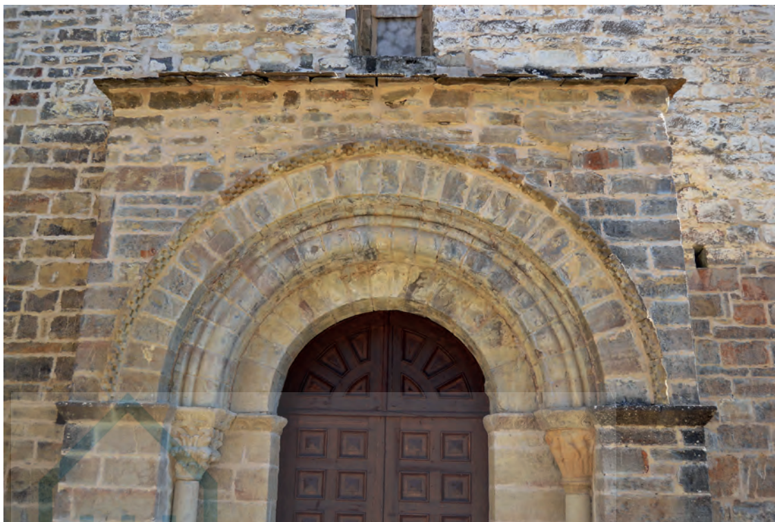
Detalle de la portada oeste
