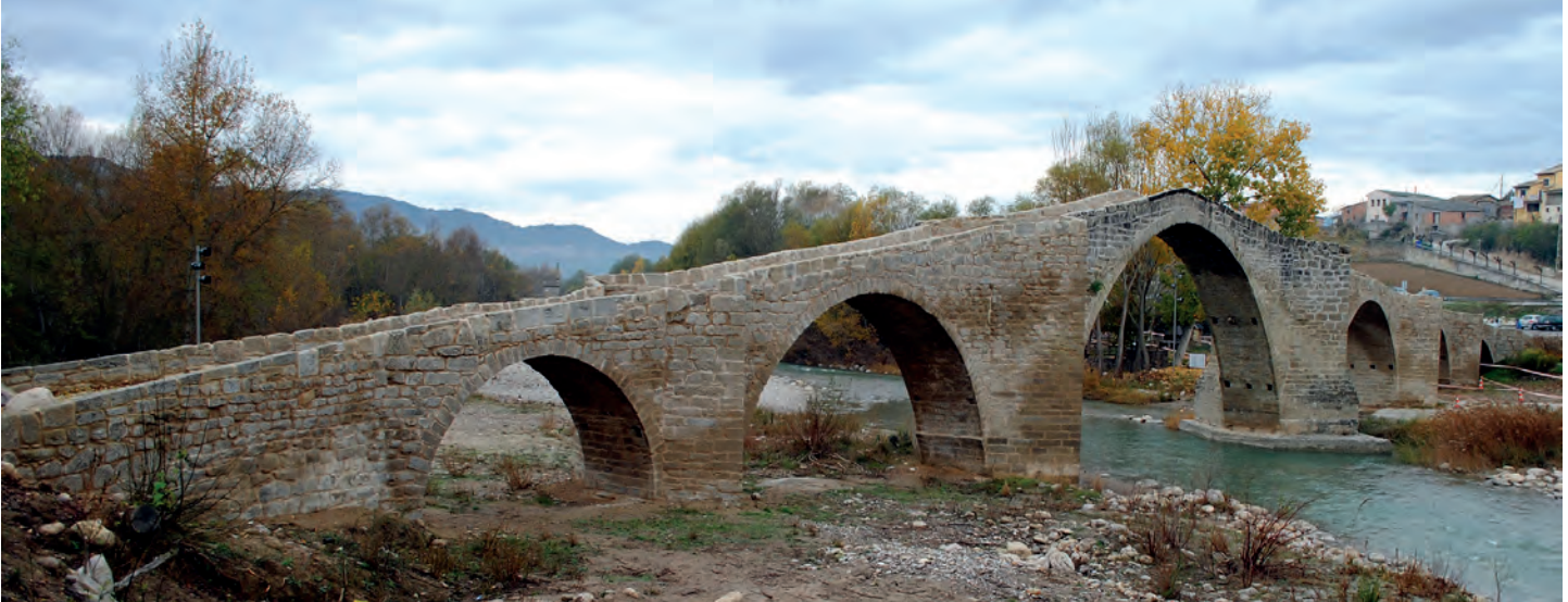
Vista del puente desde aguas abajo
