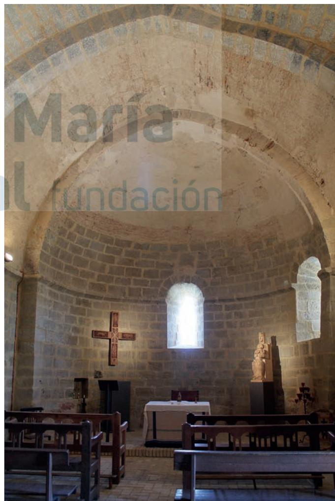
dan remarcados por un arco fajón de factura algo defectuosa y posible causa de la inclinación del muro sur. Éste se sustenta sobre dos columnas adosadas a la pared de curioso fuste, con un engrosamiento a dos tercios de su altura aproximadamente, de aparente sentido decorativo, con basa y capitel sin decoración que se apoya sobre un collarino y sobre el que discurre una imposta de perfil recto que recorre toda la nave y la parte del ábside.
