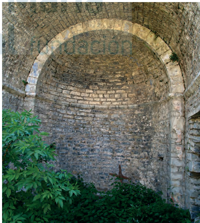
Interior del ábside
