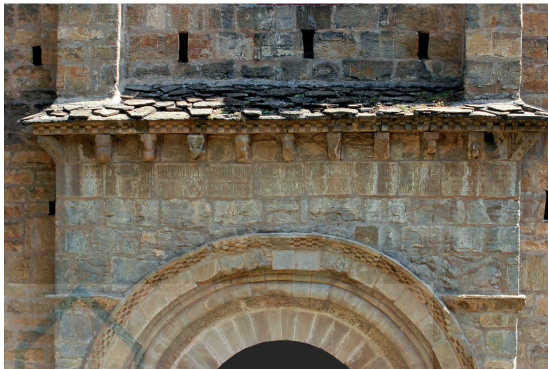
Santa María de Iguácel. Detalle de la portada occidental
