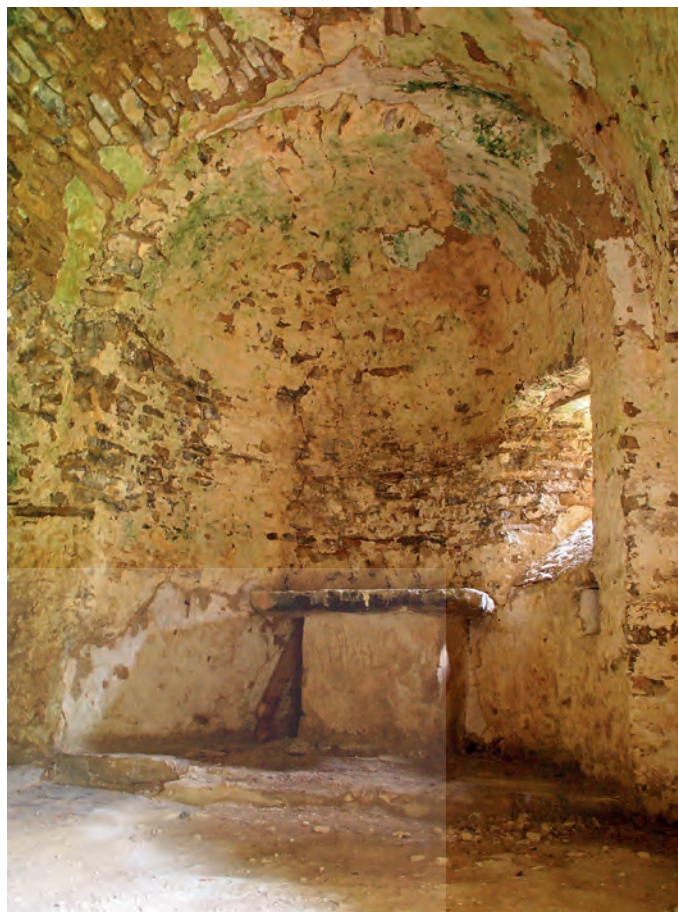
Interior del ábside
