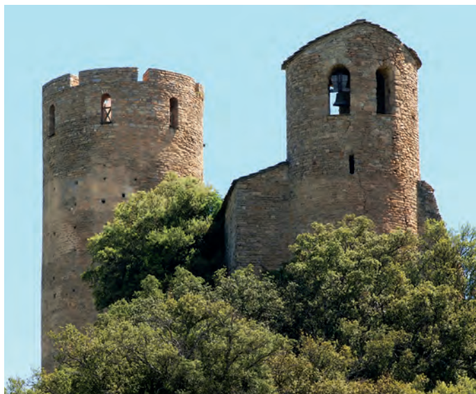
Vista de la torre circular y de la ermita
