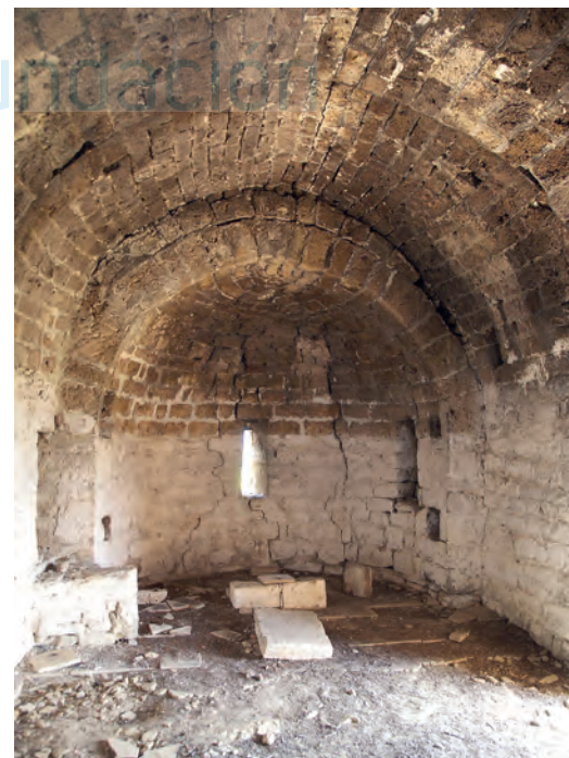
Interior del ábside
