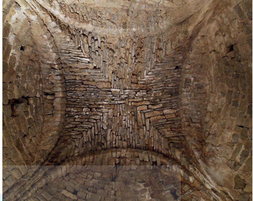
Torre circular. Bóveda del primer piso
