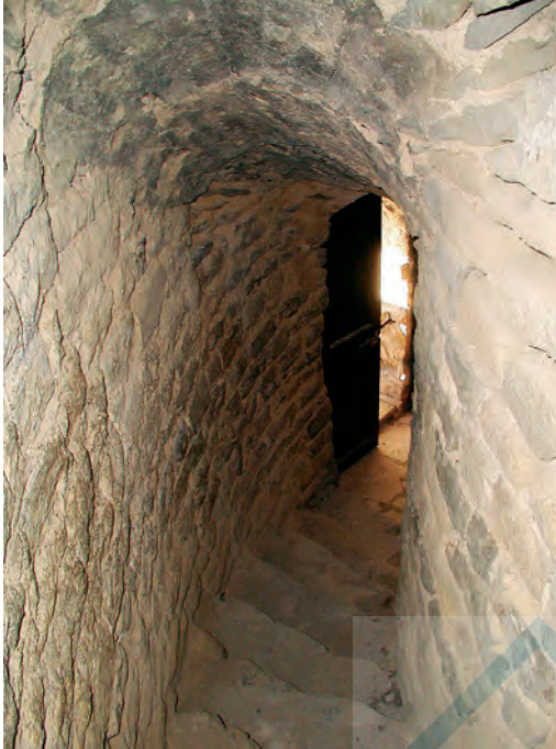
Torre circular. Escalera intramuros
