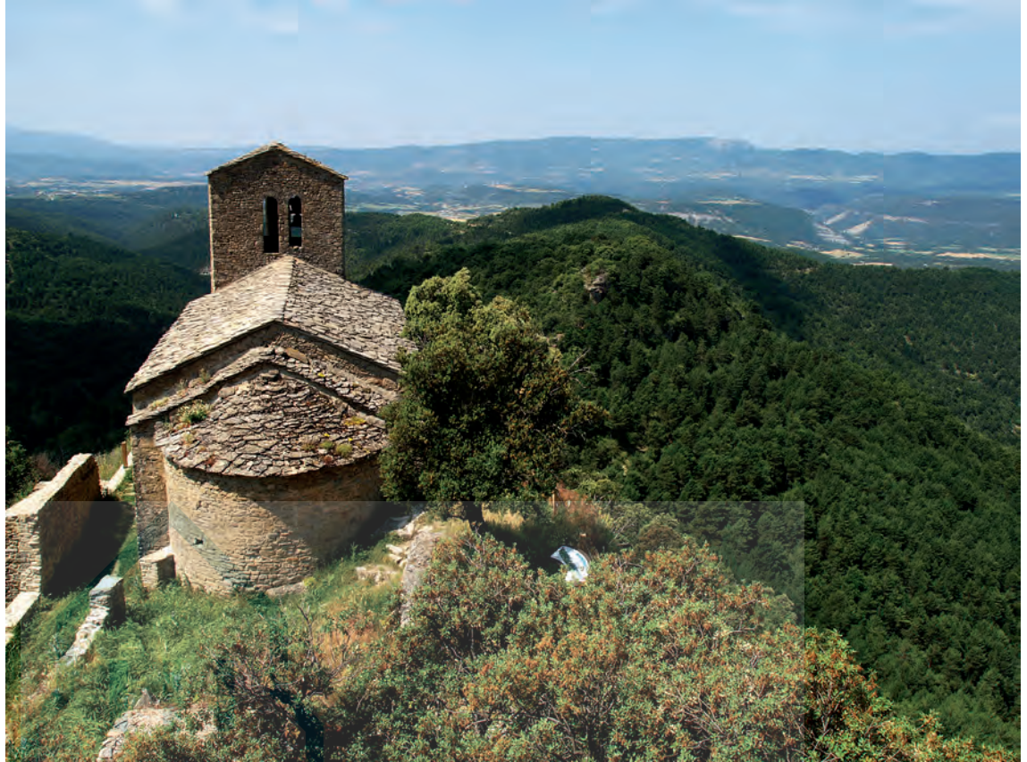
Vista de la torre circular y de la ermita
