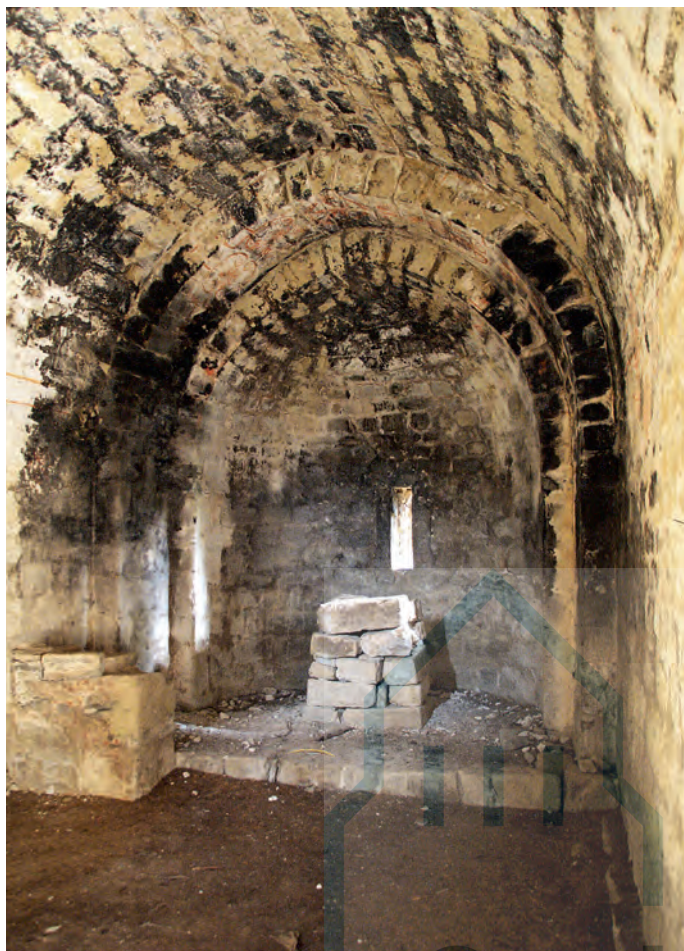
Interior del ábside
