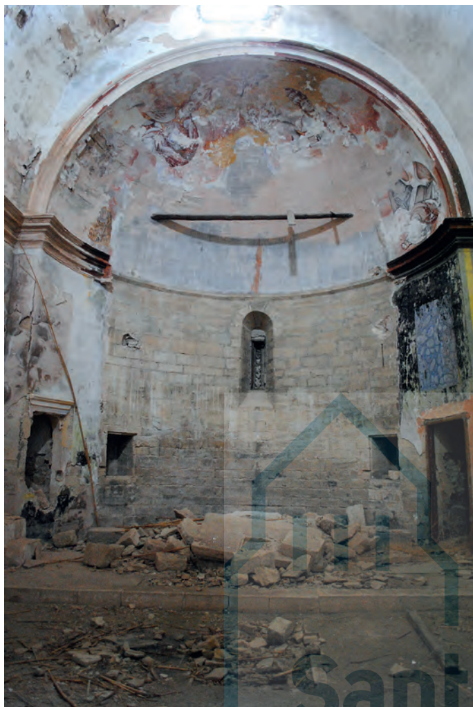
Interior del ábside
