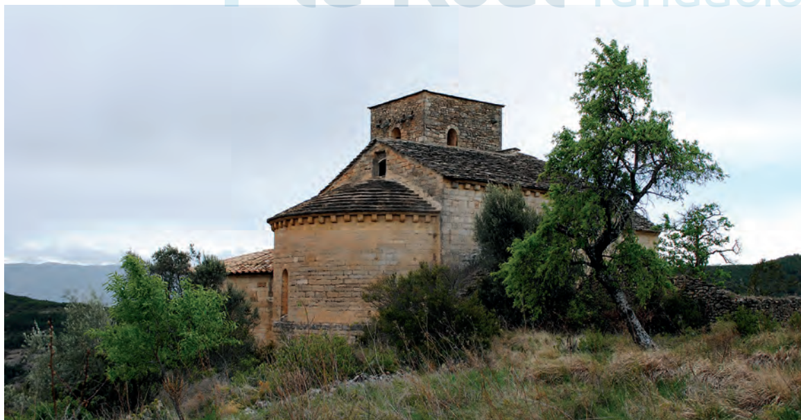
Vista general desde el lado noreste
