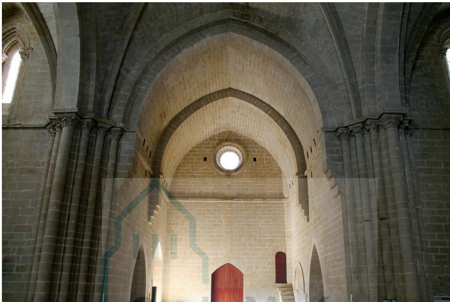
Vista del crucero y de la nave
