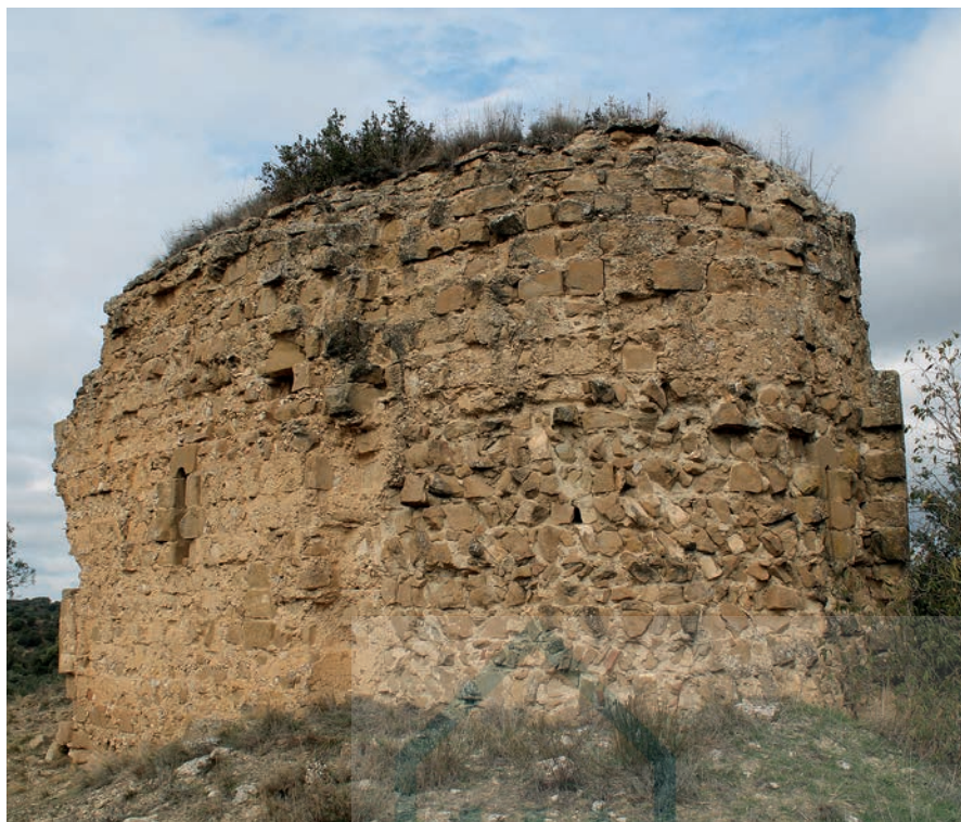
Vista desde el lado sur
