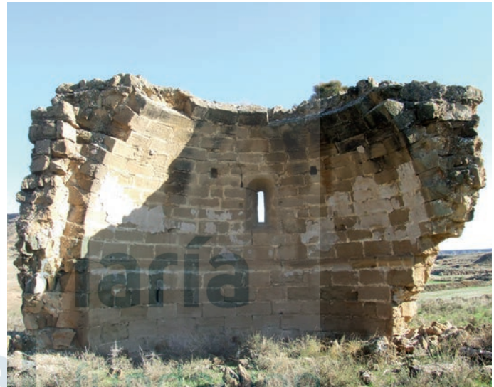
Restos del ábside
