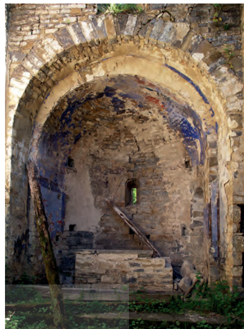
Interior del ábside
