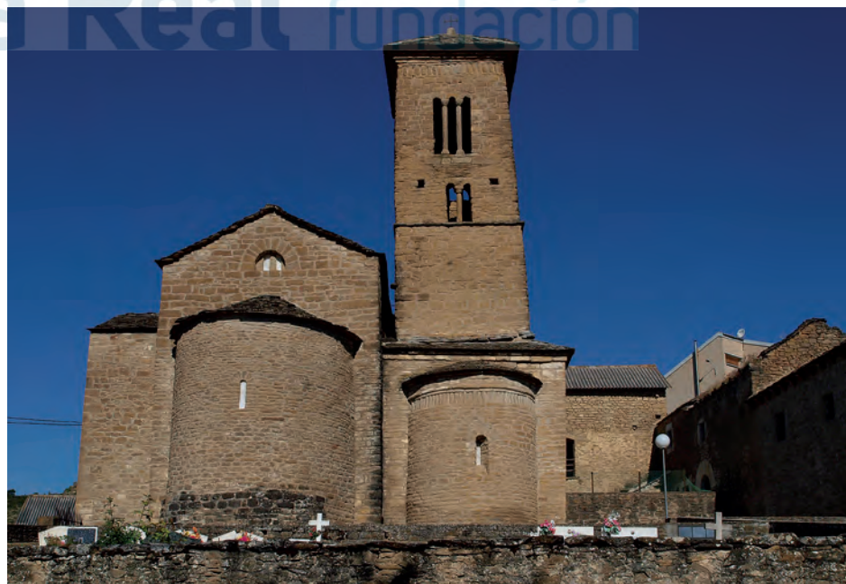
Vista general desde el lado este
