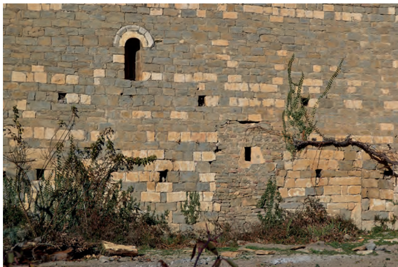
Detalle del muro sur
