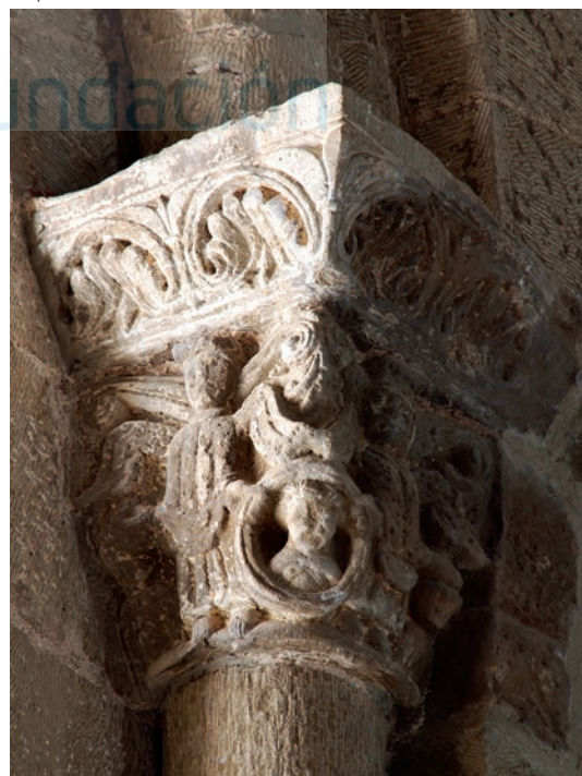
Capitel de la ventana norte
