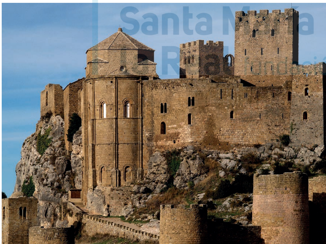
Vista desde el lado este con el muro que une la iglesia con los pabellones del lado norte
