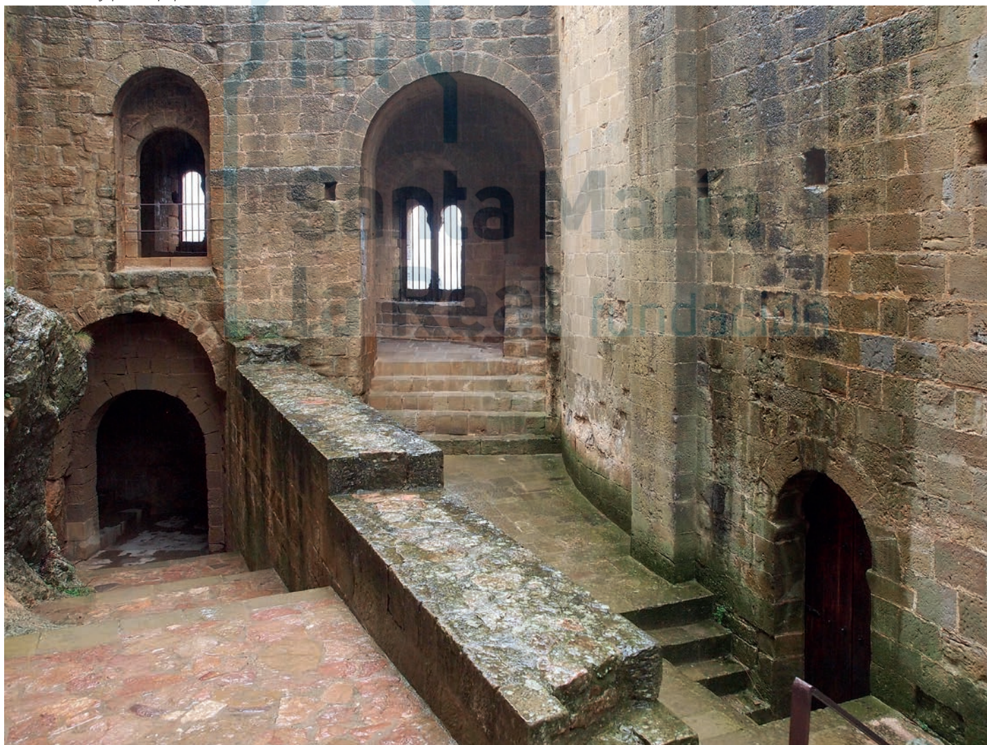
Zona de tránsito y pasos superpuestos
