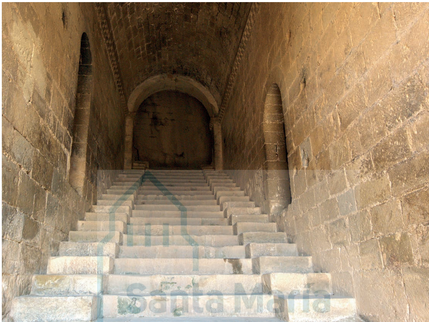
Escalera de acceso al interior
