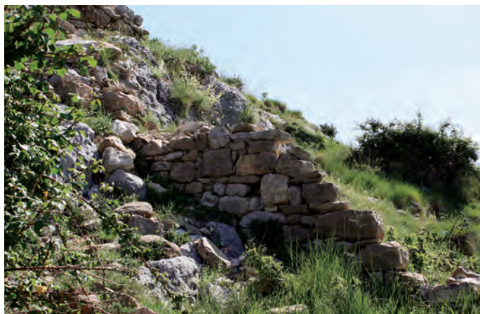
Restos de uno de los muros
