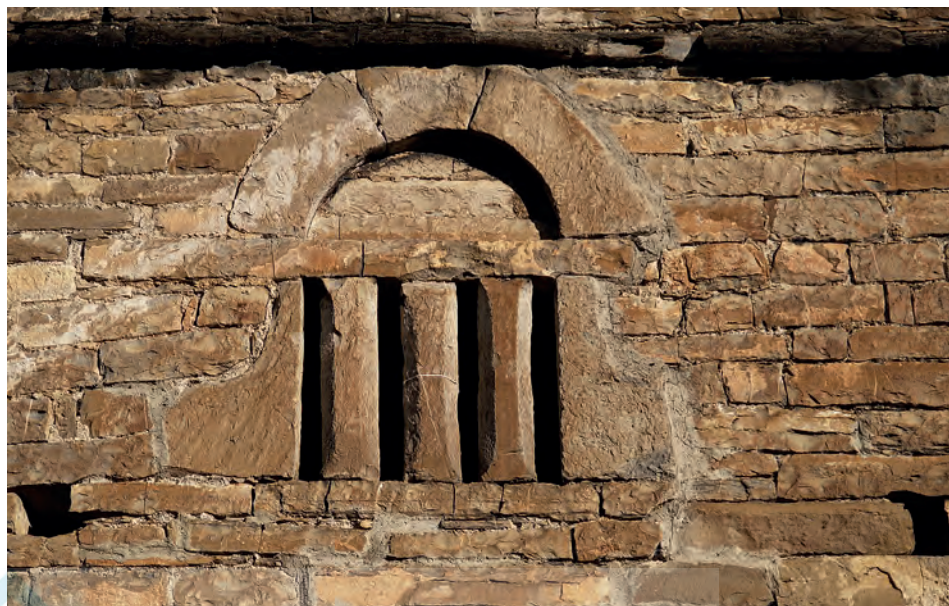
Ventana de la torre
