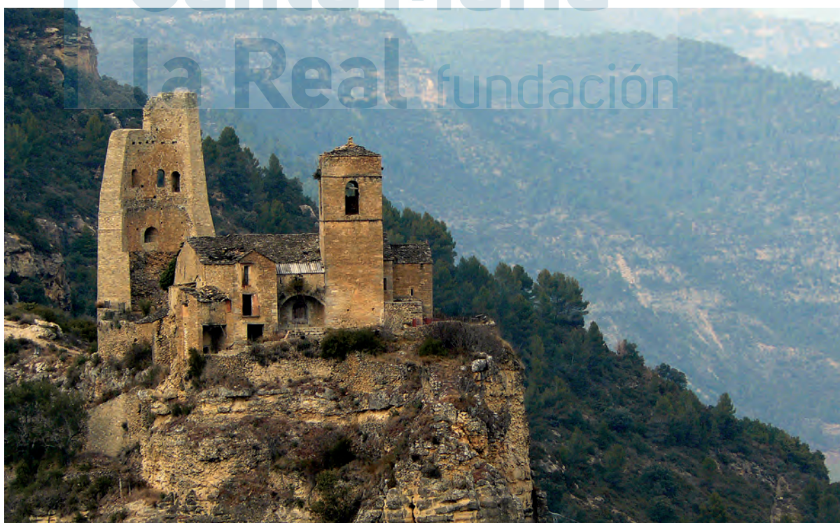
Vista general del emplazamiento
