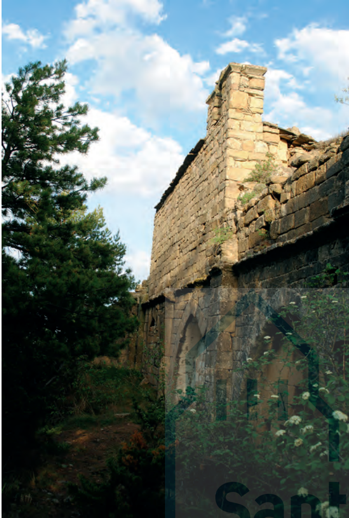
Muro de la nave
