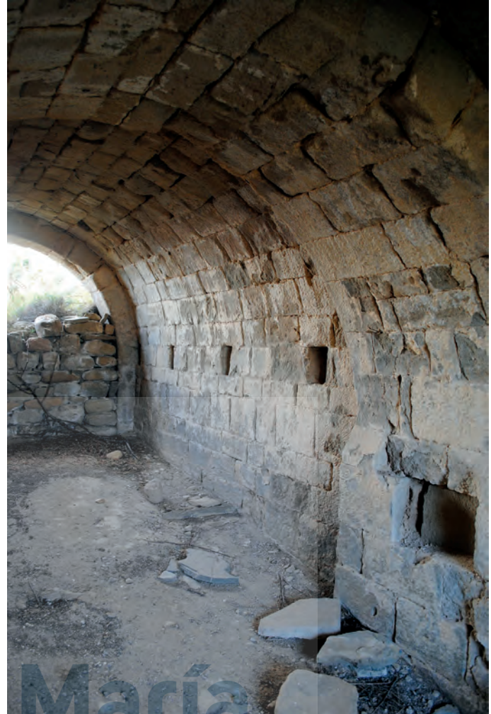
Pasadizo de la torre
