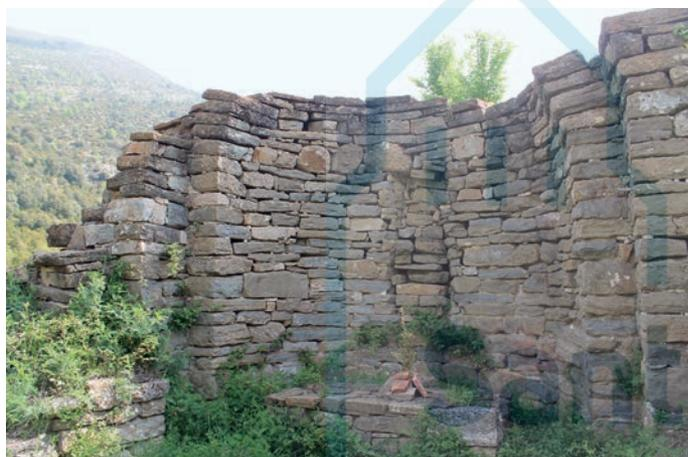
un pequeño vano donde la jamba superior y la inferior mantienen ángulo recto con el muro mientras que las laterales poseen derrame interno. Este tipo de vano difiere del resto visto en las demás iglesias de tipo serrablés, con claro predominio de vanos en arco de medio punto, por lo que no es descartable que se trate de una rectificación posterior a juzgar por la disposición de las piedras que enmarcan su entorno.
