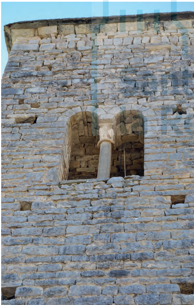
Detalle de la torre
