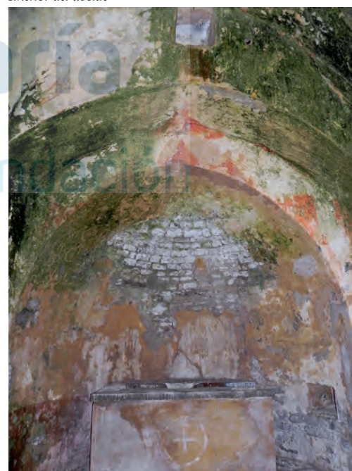
Interior del ábside
