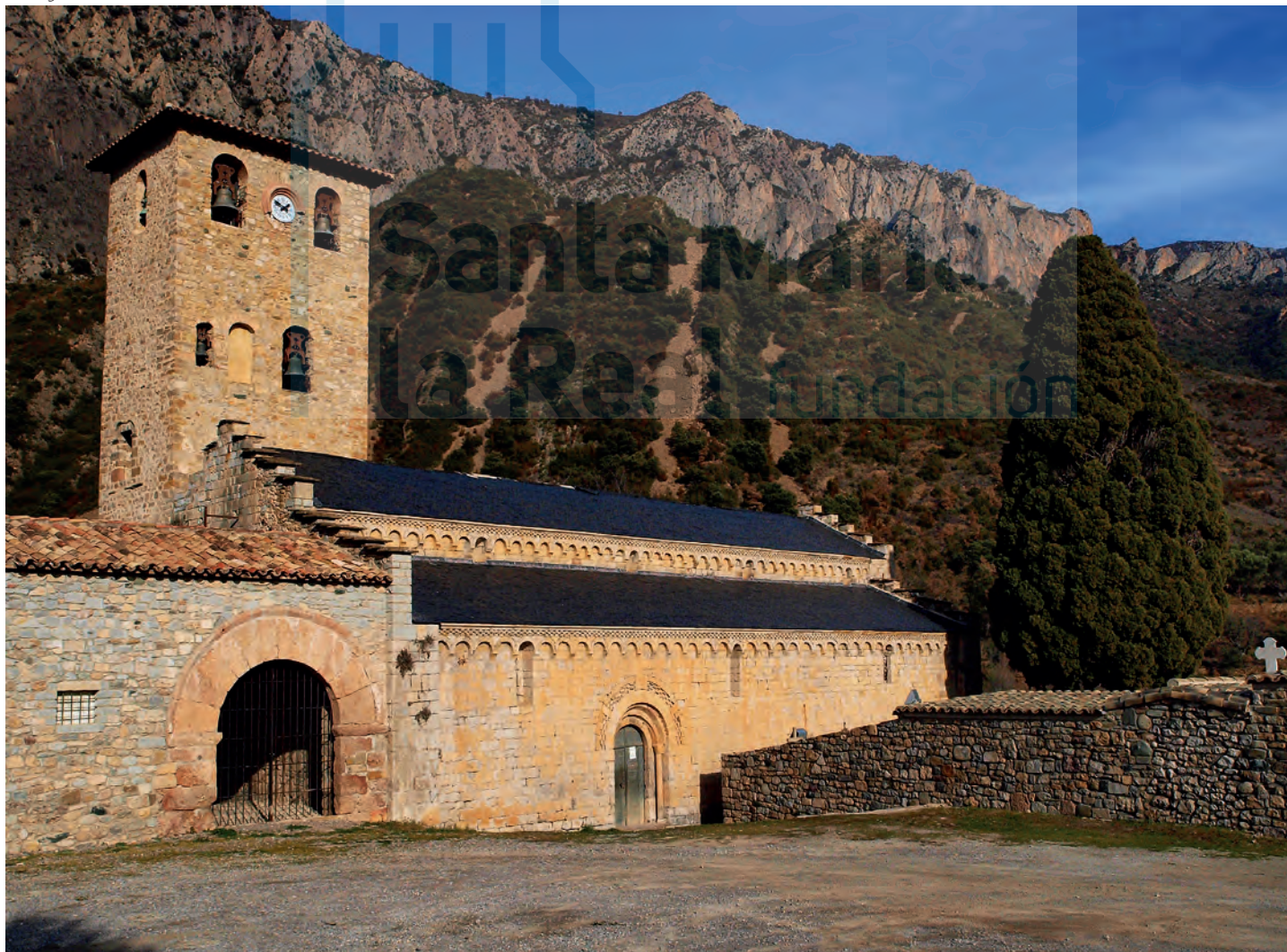
Vista general desde el lado sur
