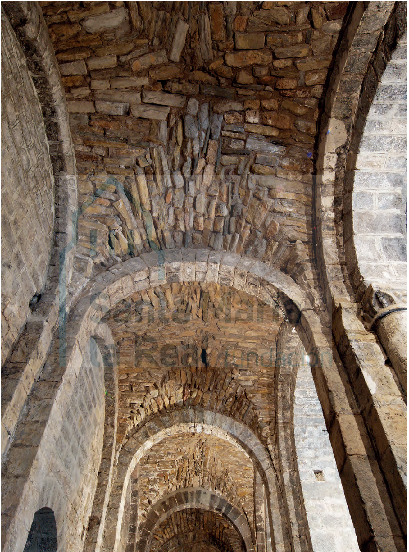
Bóvedas de la nave norte
